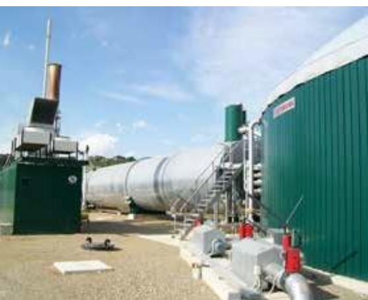
Foto a fianco L'impianto dell'azienda Stassano è dimensionato per produrre 1 milione e 60mila metri cubi di biogas all'anno che vanno ad alimentare un'unità di cogenerazione 2G Agenitor 306
